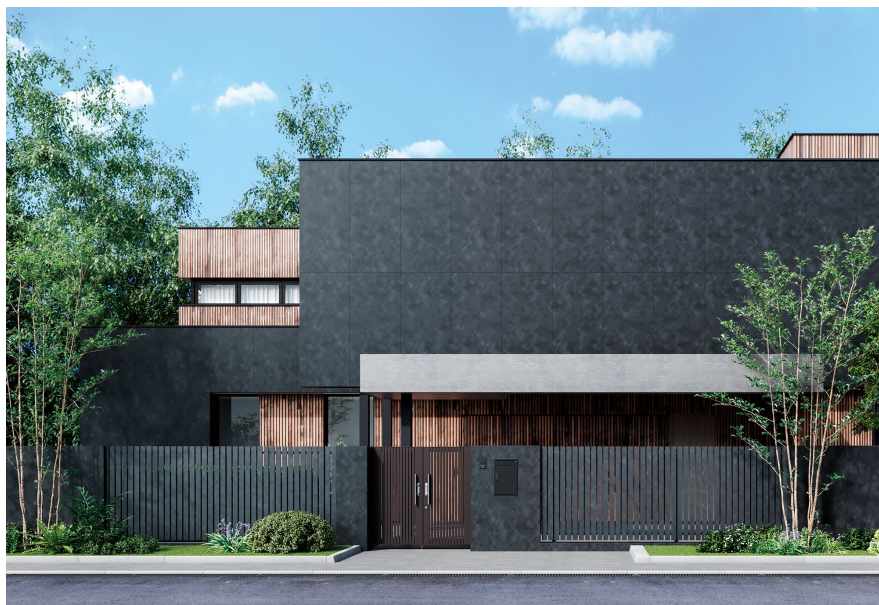
フェンス・塀・建物外壁に Texage を塗装した例。
