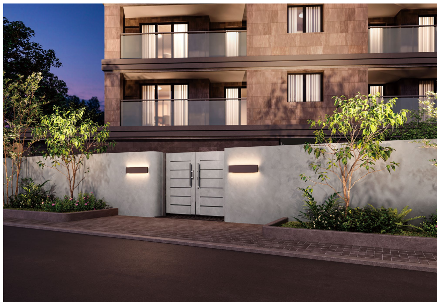
塀・門扉に Texage を塗装した例。
