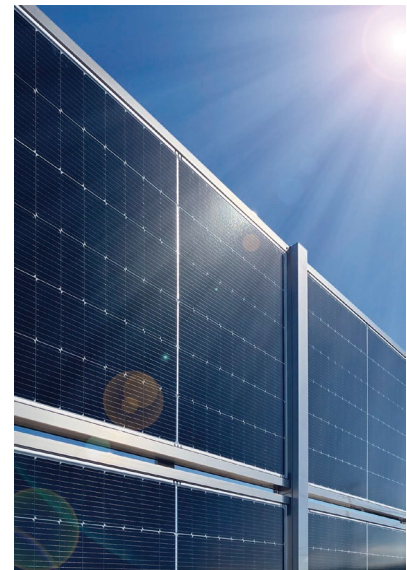
ソーラーパネルは1スパン(支柱間)につき2枚使用。
