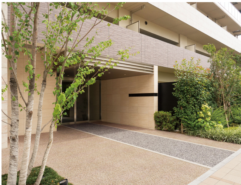
洗い出し仕上げ 施工イメージ
